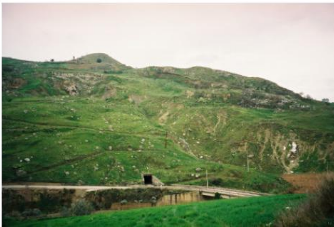
Figura 7.2.1 Miniera di Racalmuto. Galleria abbandonata per i crolli, i cui effetti sono visibili in superficie
